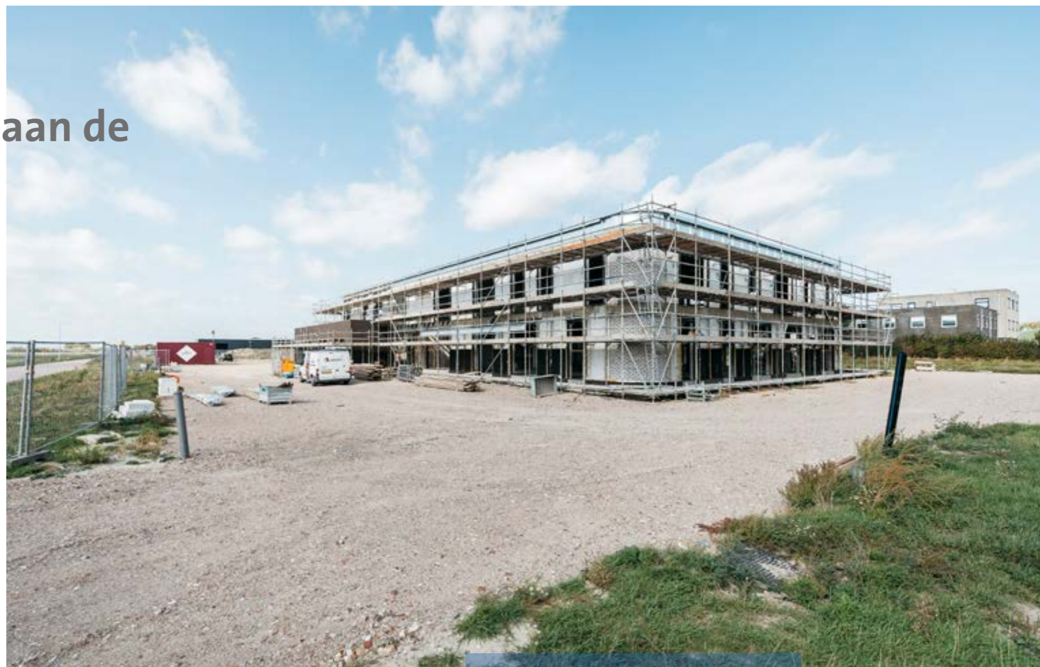
De nieuwbouw biedt alle ruimte die nodig is om de groei die Bever Innovations ambieert mogelijk te maken.
